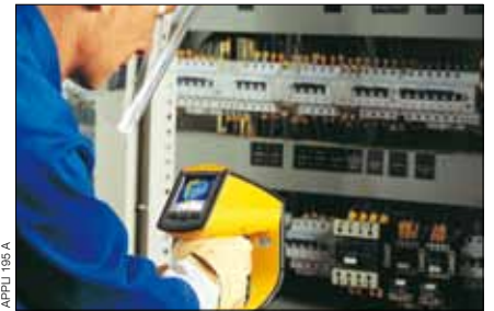
Inspecție tablou electric
